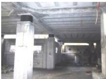
Isolateurs sur poteaux sous sol
